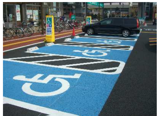
ロードコート FT (塗布型薄層カラー舗装)
