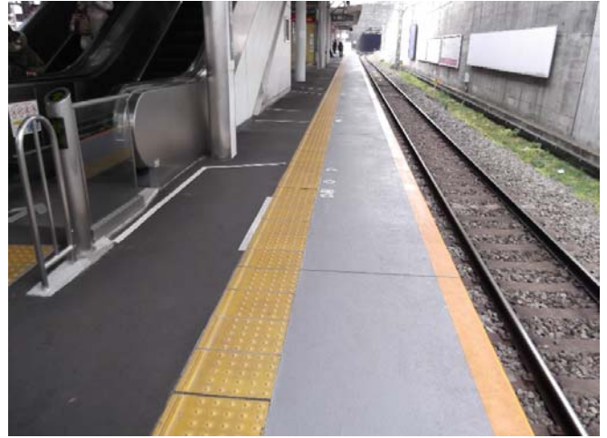
東急田園都市線 梶が谷駅 笠石ブロック部を嵩上げ+仕上げ 施工 2014年3月
