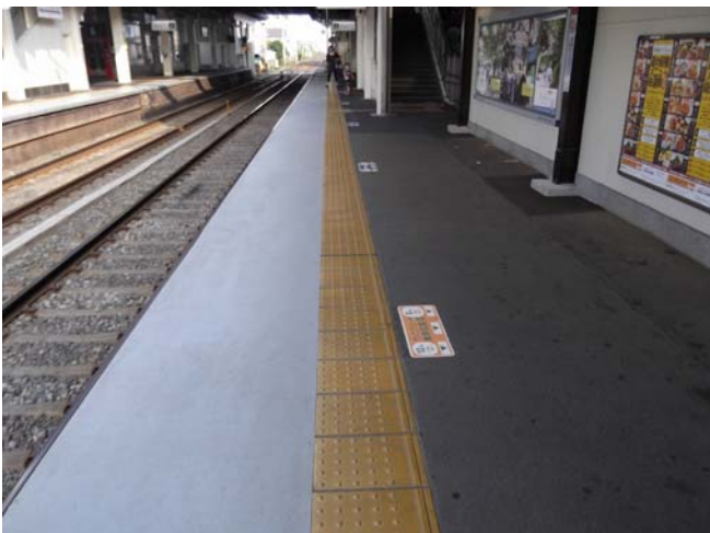
京王線 西調布駅 ホーム先端笠石ブロック部修繕工事 施工 2013年3月
