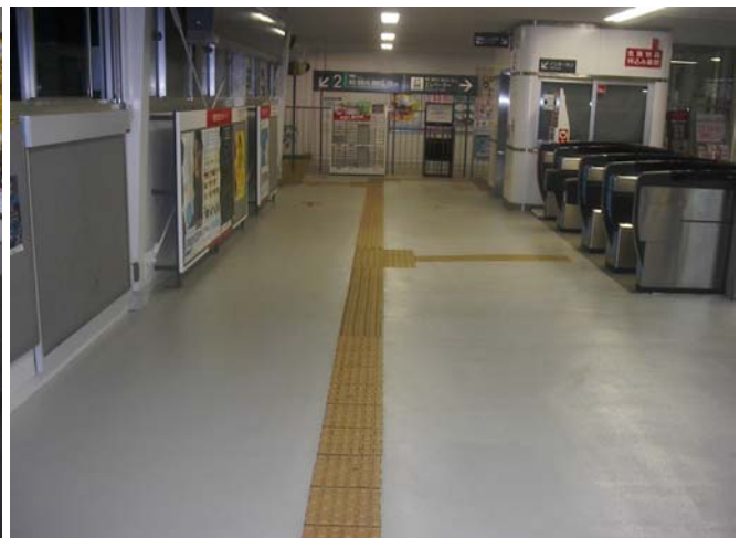
東急東横線 白楽駅 コンコースの床改修工事 施工 2011年9月
