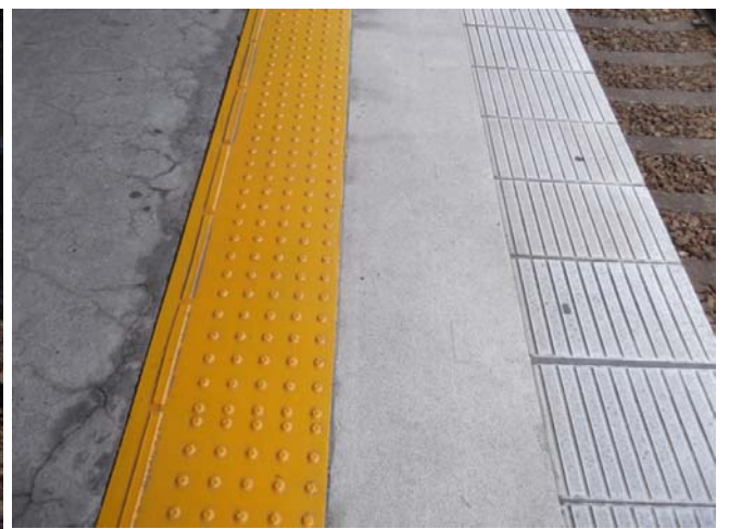
京浜急行 大森海岸駅 内方表示～点字タイル(型枠式カラータイル)および点字タイルと笠石の間 施工 2013年3月
