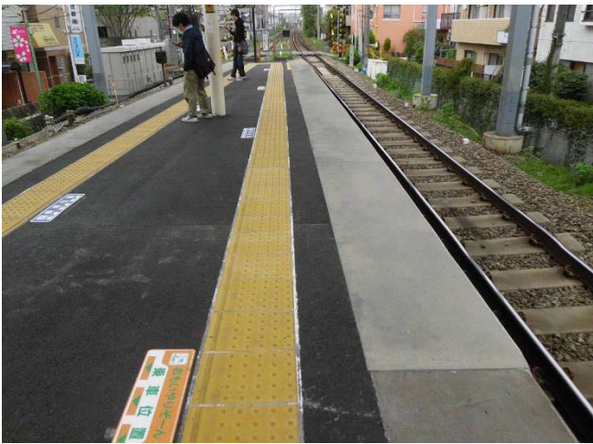
井の頭線 西永福駅 ホーム先端笠石ブロック部勾配修繕工事 施工 2012年3月
