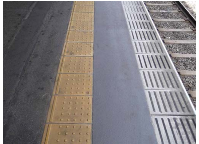
京王線（笹塚駅笠石～点字ブロック間） AS舗装の既設表示の消し込みと美装化 施工 2012年11月
