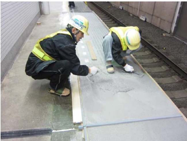
東急田園都市線 梶が谷駅 型枠設置後樹脂モルタル打設状況 既設のゴム入り笠石ブロックの上に増し厚施工 施工 2014年3月
