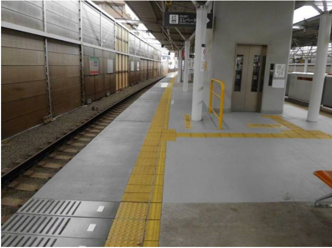
東急東横線 新丸子駅 ホーム先端笠石ブロック部勾配修繕工事 およびホーム舗装美装改良工事 施工 2011年12月
