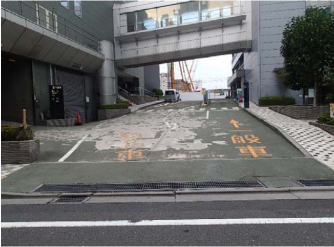
施工前(既設:エポキシ系滑り止め舗装)
