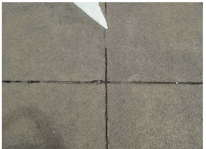
写真4. 構造目地部(2016年4月撮影) 構造目地を埋めた樹脂にクラックの発生がない
