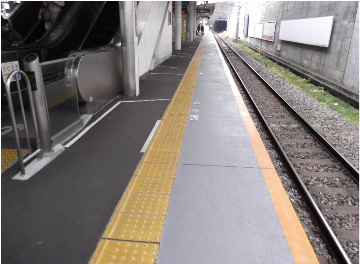
東急線「梶が谷駅」(嵩上げ勾配改修)
