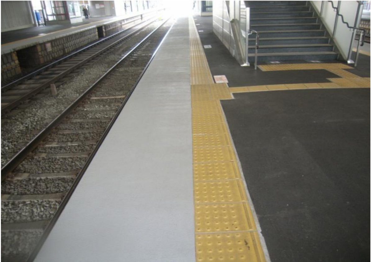
京王線「東府中駅」(笠石修繕)
